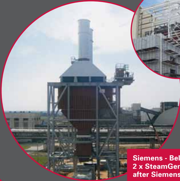
E4 Group - Borisov SteamGen™ 8 HRSG after Siemens SGT 800
